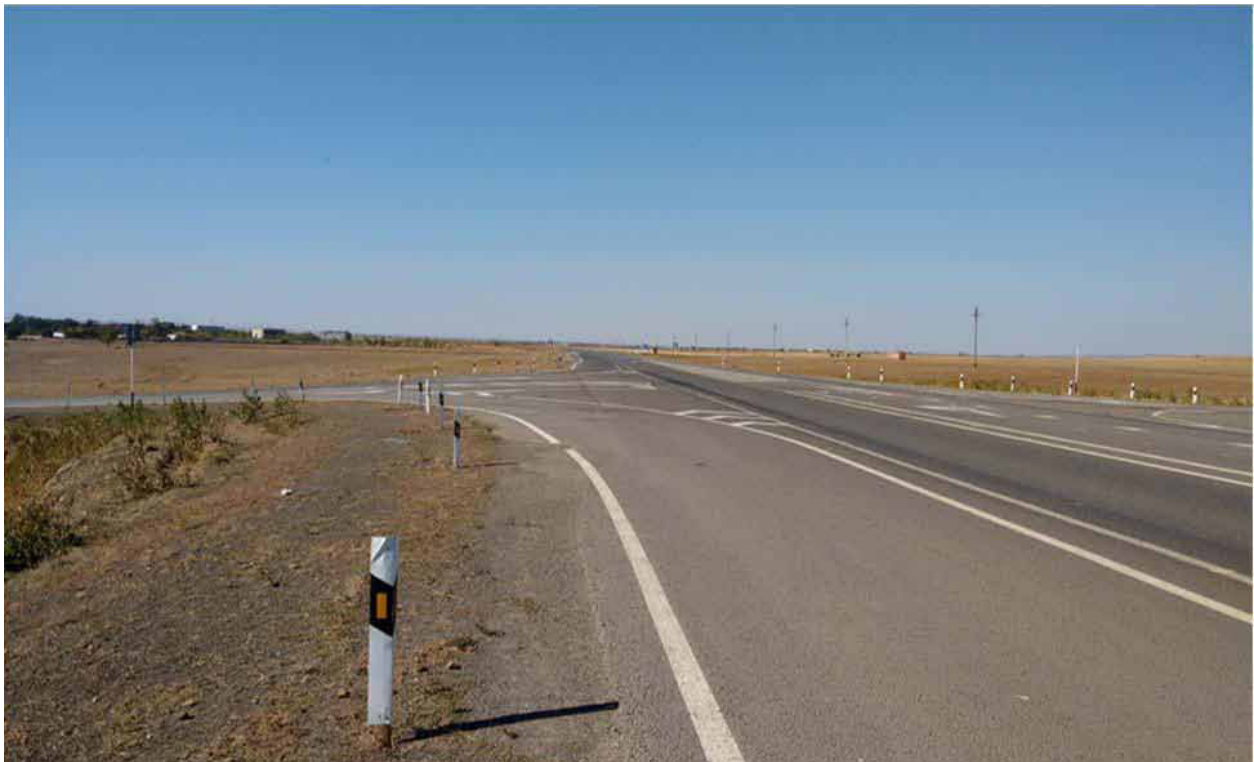
Пересечение на недавно восстановленном участке А-27, в 25 км к северу от места начала предложенных работ.1
