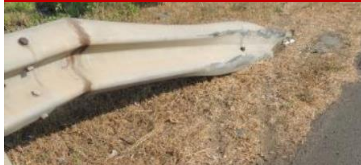
Сужающиеся концы отбойников могут подбросить в воздух автомобиль, движущийся на большой скорости
