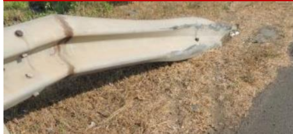
Төмөр туузан хаалтны үзүүр нь хурдтай тээврийн хэрэгслийг агаарт хөөргөх болзошгүй
