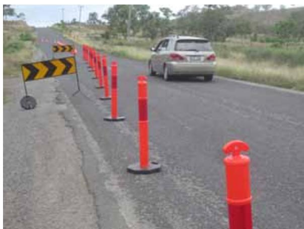
Любые устройства, используемые для обозначения краев полосы движения должны быть хорошо видимыми, щадящими при ударе, и иметь отражающие свойства. Переносные пластиковые столбики высотой 1200 мм являются отличными делинеаторами. Они имеют тяжелое основание, удерживающее столбик в вертикальном положении, почти при любой погоде.
