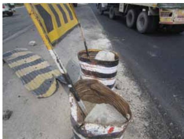
Хорошие средства разграничения полос движения необходимы на участках дорожных работ, однако они должны быть неповреждающими и иметь светоотражающие свойства. Бетонные блоки, вставленные в раскрашенные бочки, являются источником опасности.
