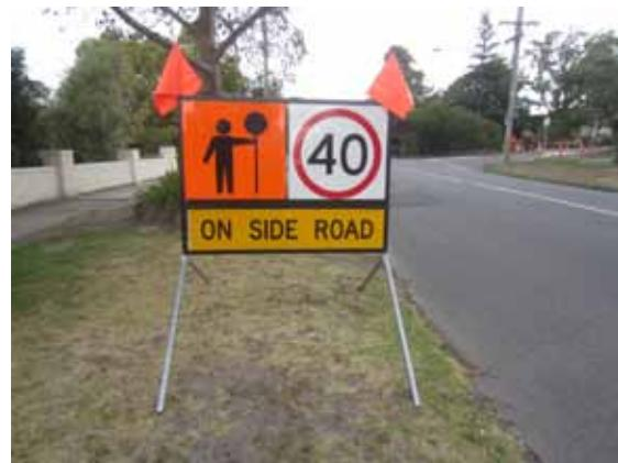
Сообщения можно быстро менять, чтобы точно отражать тип работ, производимых в данный момент. Знаки, регулирующие движение, должны соответствовать национальным правилам дорожного движения, чтобы обеспечивать исполнение их требований.
