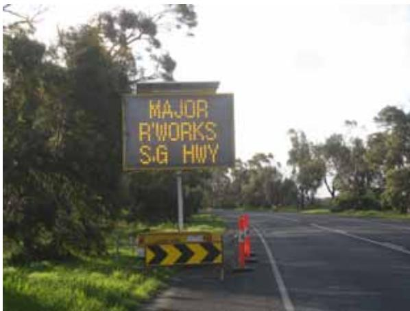
Пример ТПИ, установленного на прицепе, расположенным на обочине сельской автодороги с ограничением скорости до 100 км/час (движение по левой стороне)
