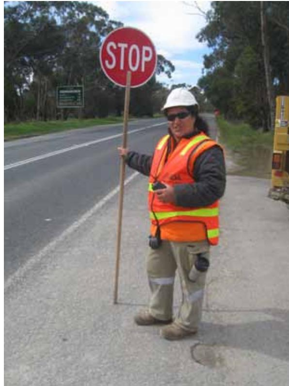
Рабочие и регулировщики движения должны быть обеспечены личным защитным снаряжением, соответствующим климатическим условиям. Снаряжение должно включать жилет или куртку высокой видимости, которые хорошо заметны в дневное время и хорошо отражают свет в ночное время.
