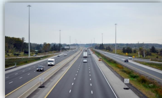
Строительство автомагистрали Восток – Запад
