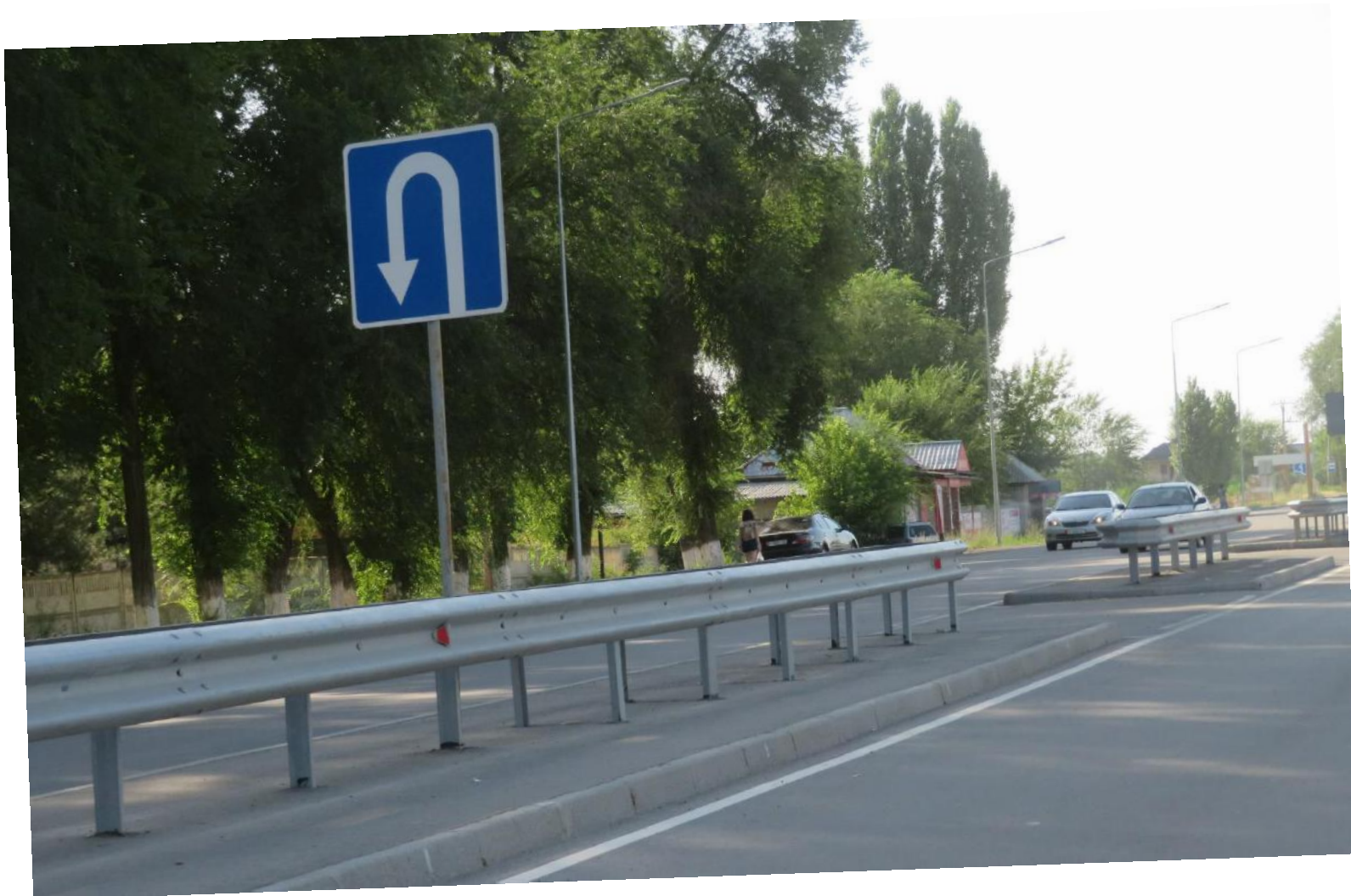
Разрыв разделительной полосы с очень высоким риском
