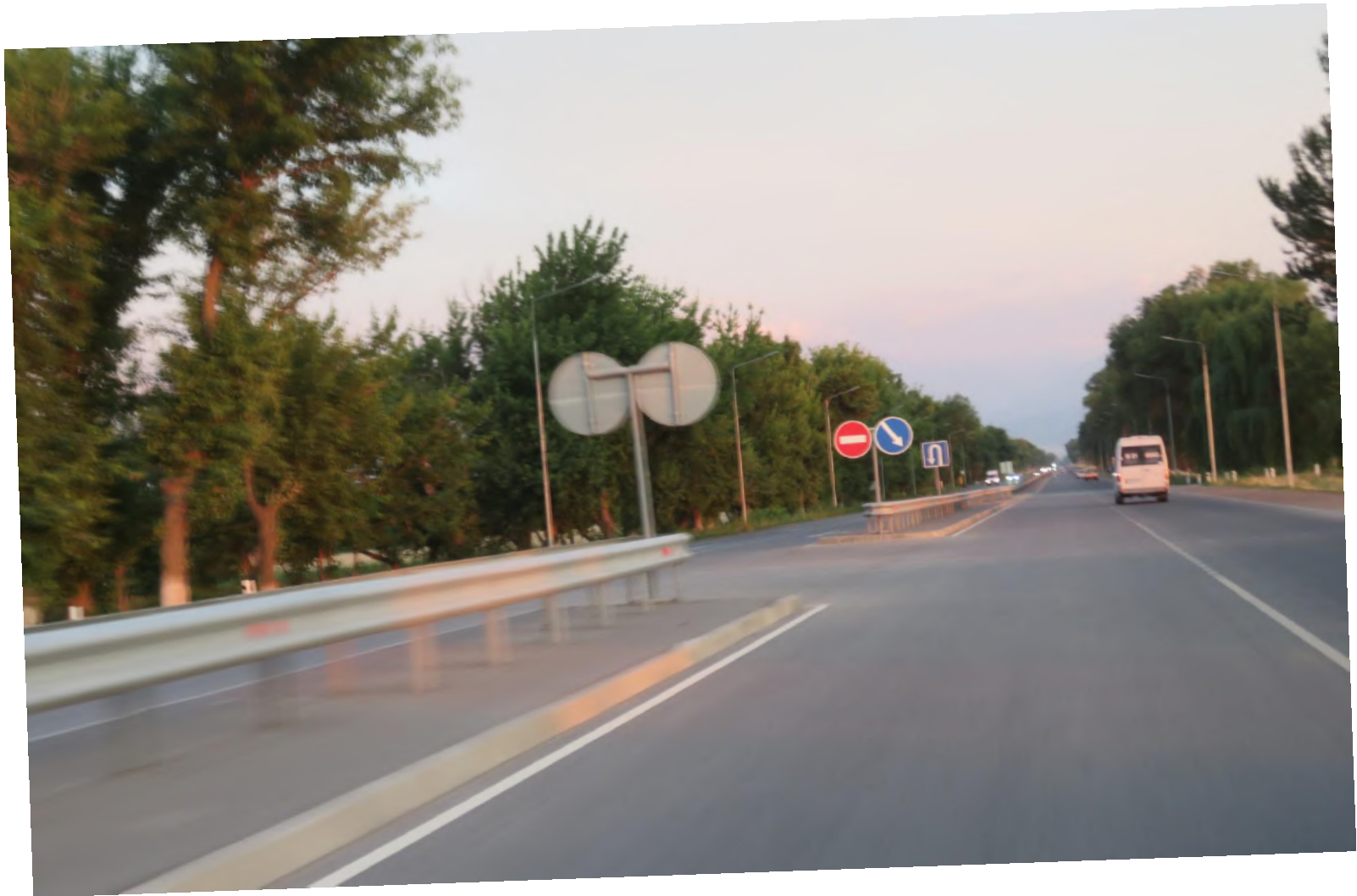
Разрыв разделительной полосы с очень высоким риском
