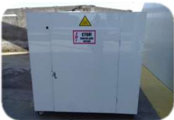
Фумигационные камеры – 95 units
