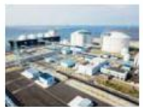
Hibi LNG Co., Ltd. Hibi LNG Terminal
